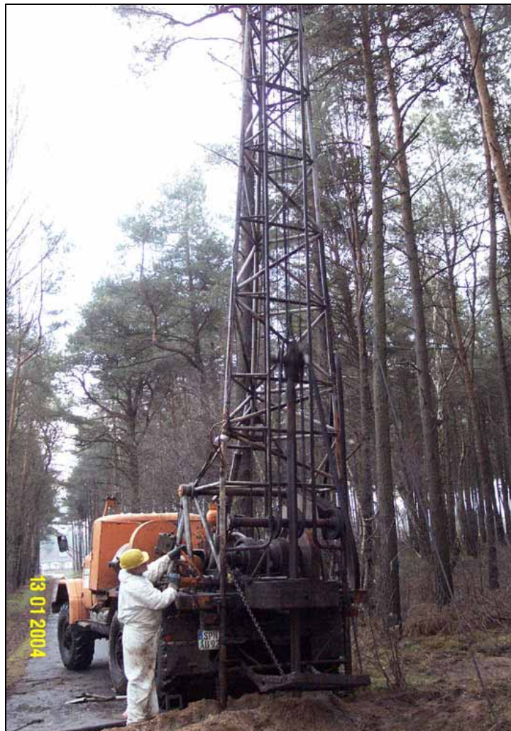
Abb. 12: Bohrarbeiten zur Erkundung offener Strecken (Quelle: DMT-GU GmbH Leipzig)
