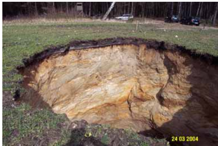
Abb. 14: Altbergbauggebiet Malliß / Conow; Stollen Conow VI; südl. Begleitstrecke Tagesbruch vom März 2004 (Foto: DMT-GU GmbH Leipzig)
