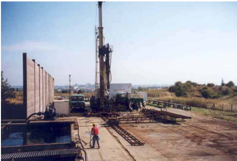
Abb. 1: Bohranlage zur Aufwältigung und Uminstallation der Geothermiebohrungen Neubrandenburg
