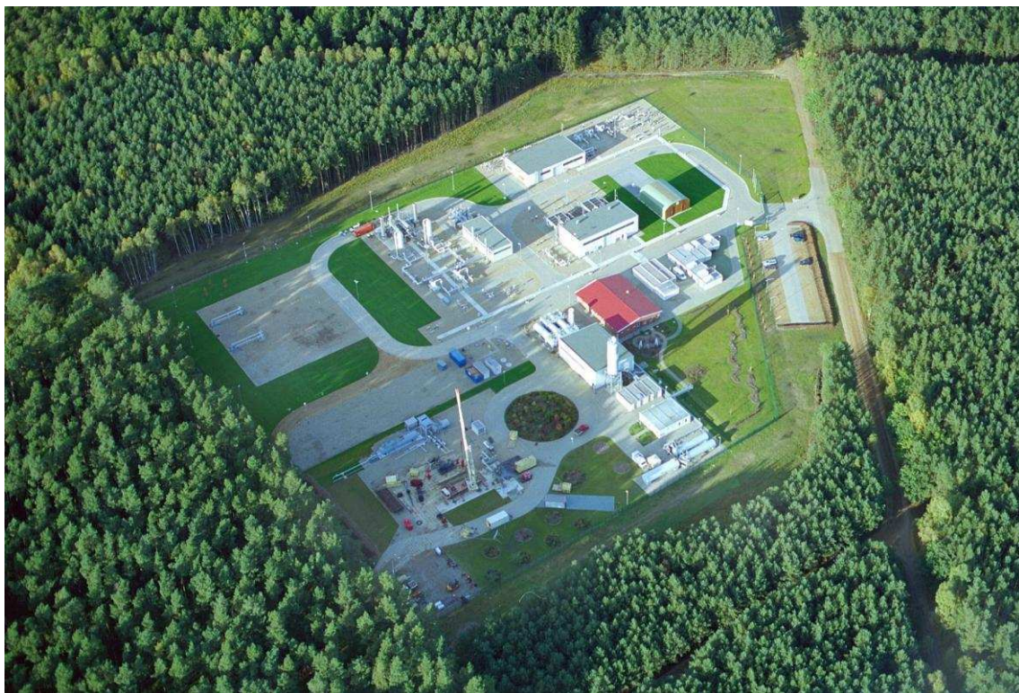
Abbildung 5 – Gesamtansicht des Betriebsgeländes Kraak
