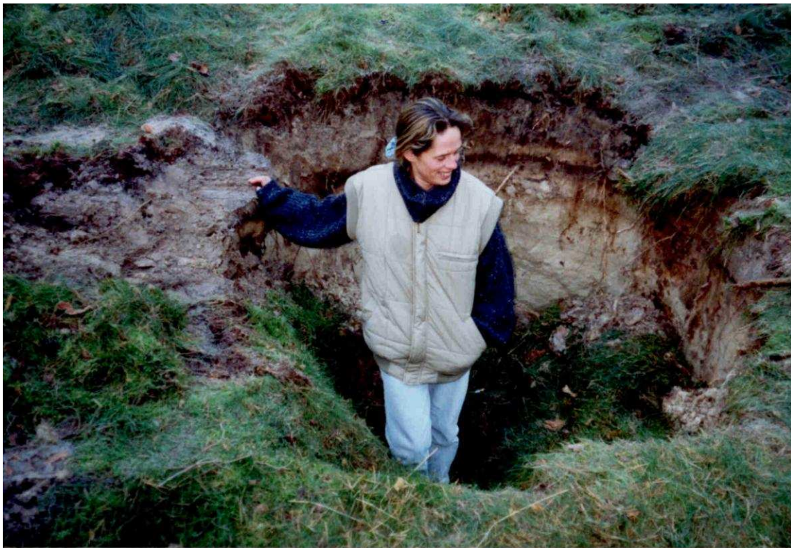
Abbildung 13 – Tagesbruch im Braunkohlenaltbergbaugebiet Malliß
