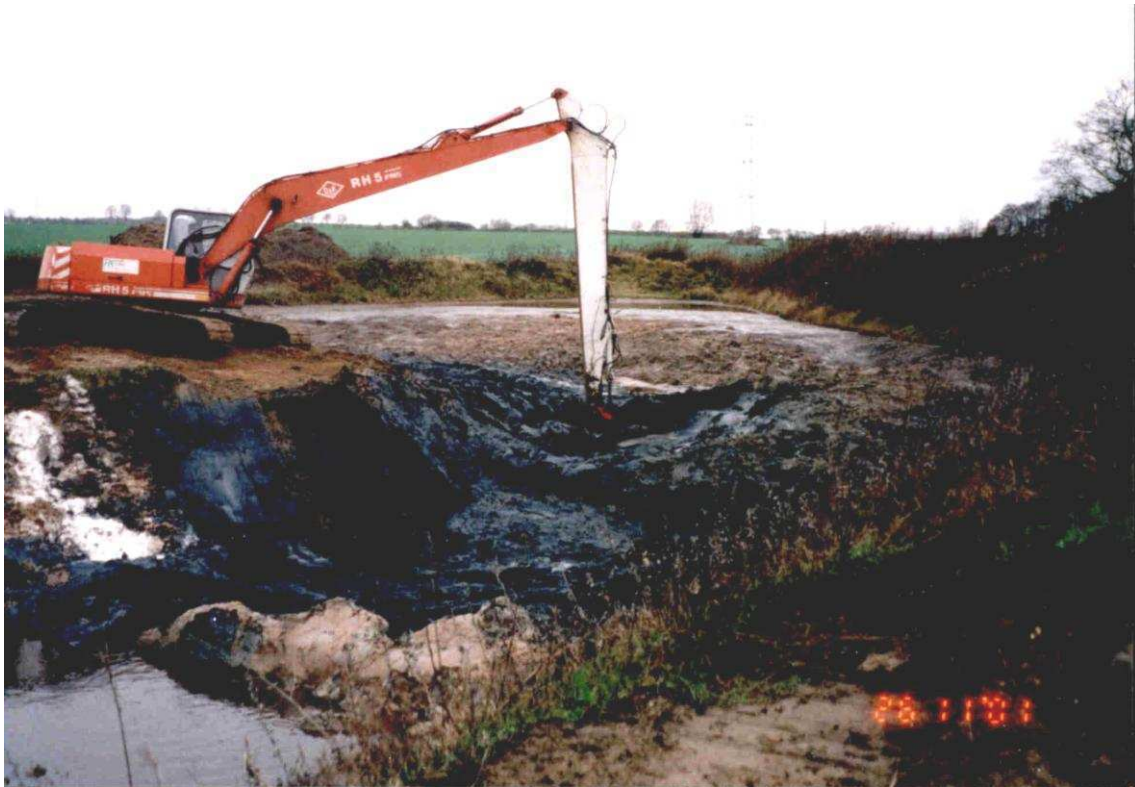
Abbildung 4 – Altbergbauobjekt Schwerin 1 während des Rückbaus
